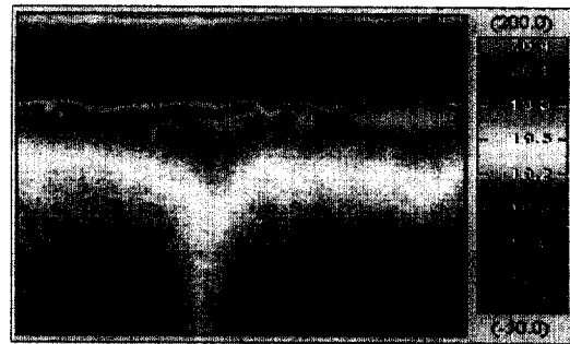
그림 5. 전산실 외벽 내표면의 적외선 사진
