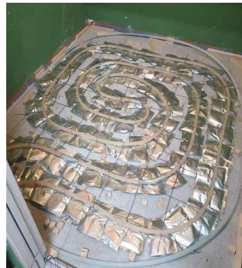
Fig. 1 Mock-up 평면도 및 PCM 설치 사진
